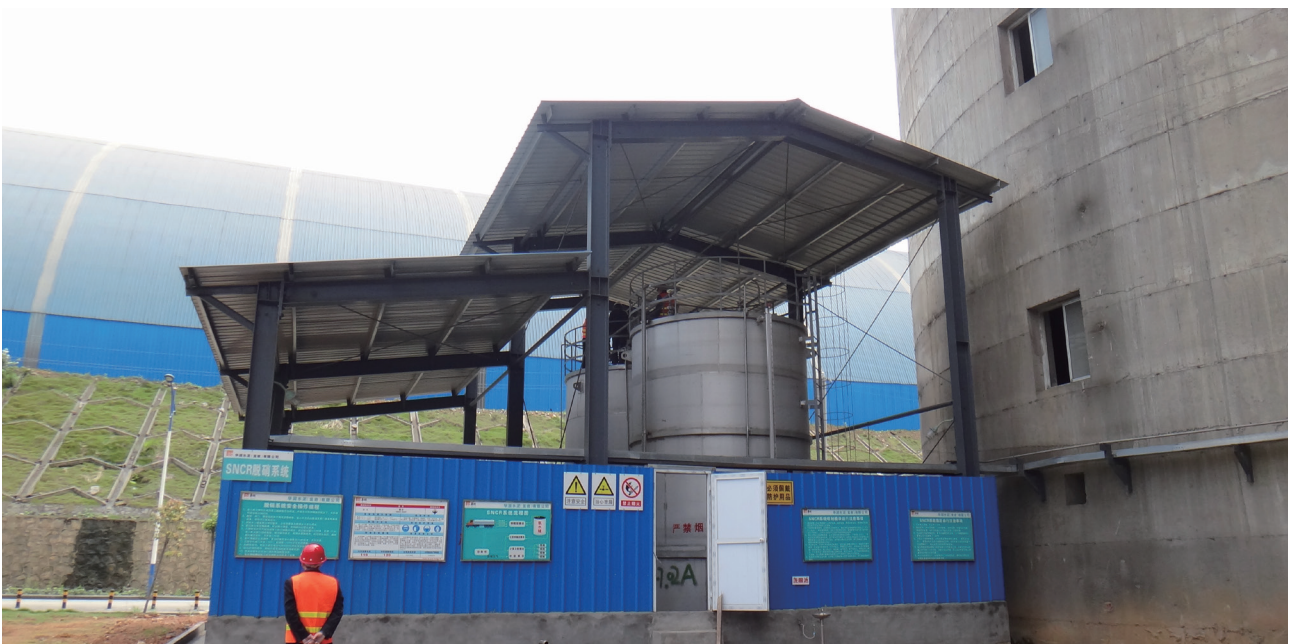
华润水泥龙岩公司SNCR脱硝系统
